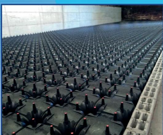
Fig.6 Esempio di installazione geoblocchi insuflazione biocella
