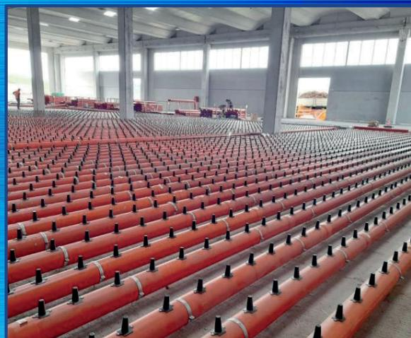
Fig.5 Esempio di installazione spigot insuflazione biocelle
