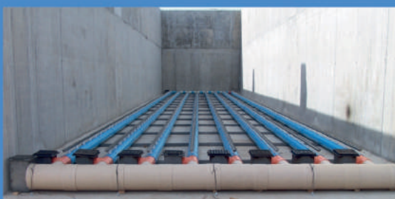
Fig.5 Esempio di installazione spigot insufflazione biocelle Example of installation spigot Biocells insuflation
